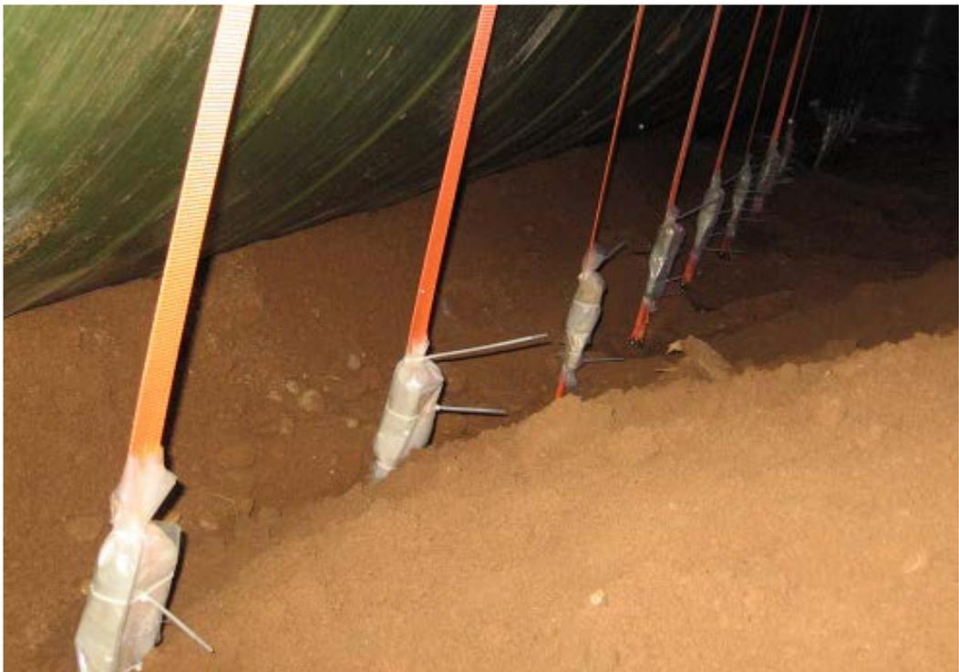
**Установка емкости на плите, крепление стяжных ремней**
